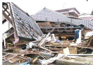
阪神淡路震災で倒壊した住宅
